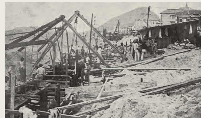
Obras de reconstrução da Avenida Atlântica. Fon-Fon , 20 de maio de 1922, p. 26.
