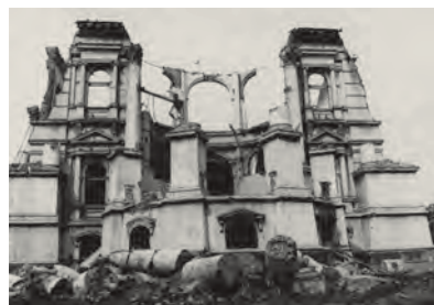
Demolição do Palácio Monroe, 1976. Acervo Biblioteca Nacional.
