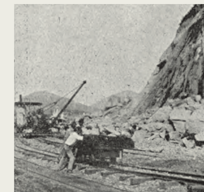
Avenida do Contorno em construção. Fon-Fon , 17 de junho de 1922, p. 16.
