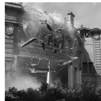
Demolição de arquibancadas do Estádio das Laranjeiras. Acervo Flu Memória.
